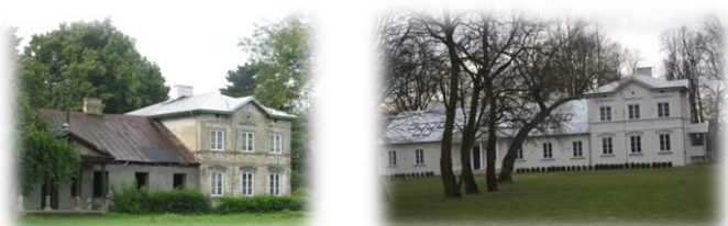
Fot. Dwór w Turowicach przed (2011) i po remoncie (2016 r.)
