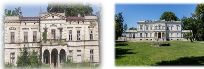
Fot. Pałac w Boglewicach przed (2011 r.) i po remoncie (2016 r.)
